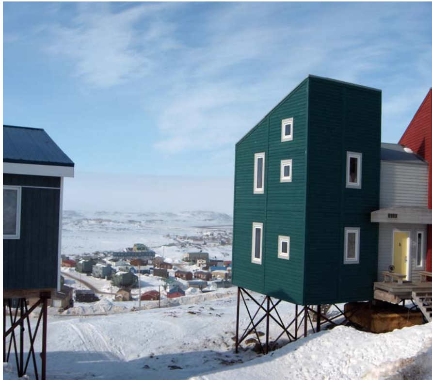
Houses on Piles, Iqaluit NU (J. Shirley, 2004)
